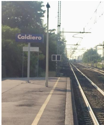
Fig. 5 – Fermata con tabella di orientamento di fine marciapiede
